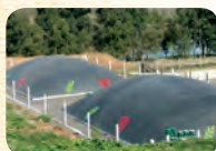
Biodigestores São Paulo, Brasil
